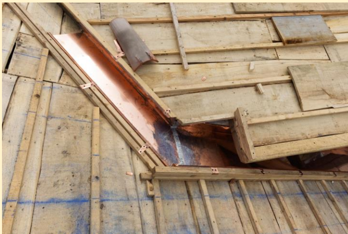
Soudure à l'étain et fixation avec des agrafes en cuivre
